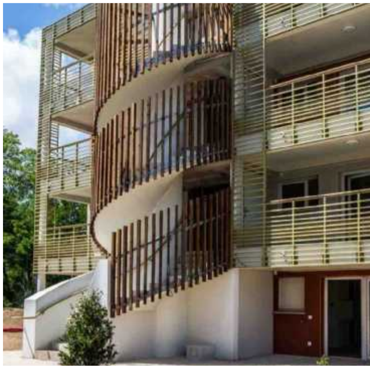
Bayonne accueille, dans son écoquartier du Séqué, un habitat participatif, la résidence Terra Arte. PHOTO ARCHIVES « SUD OUEST »
